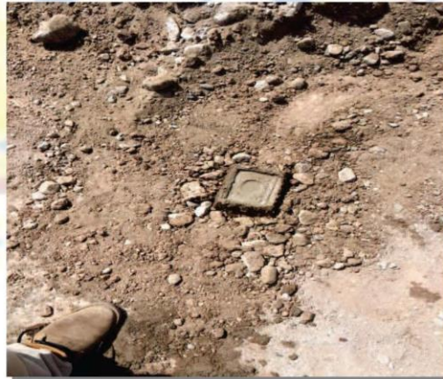
Fotos 5,6 y7. Construcción del monumento CRB04
