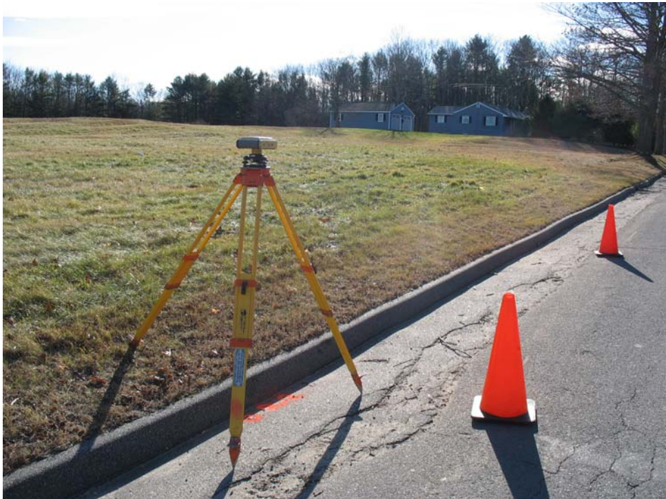
OOB P10 - Pavement
